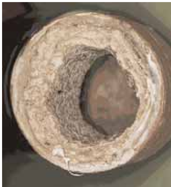
◀ Verschlammte Ablaufleitung
